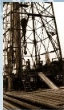
Torre de Perforación Década de los '50
